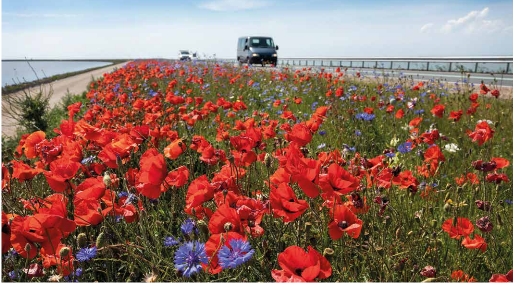
Bloemrijke berm met natuurlijke vegetatie beschermt de dijk beter (Houtribdijk).
