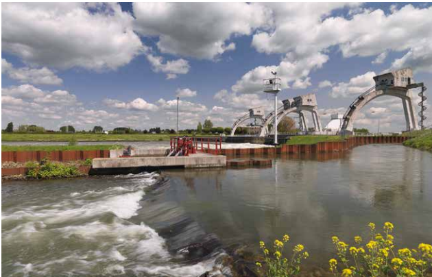
Vistrap bij het stuwcomplex bij Hagestein, waardoor de vissen omhoog kunnen zwemmen bij gesloten stuw.
