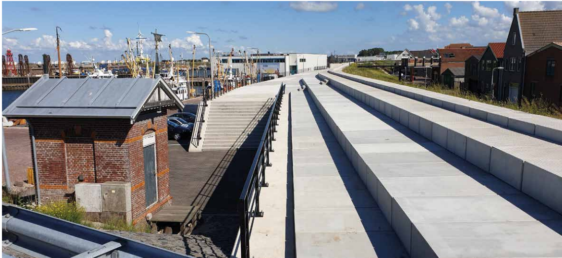
Getrapte dijkbekleding in de haven van Den Oever zodat bezoekers kunnen uitkijken over de haven.
