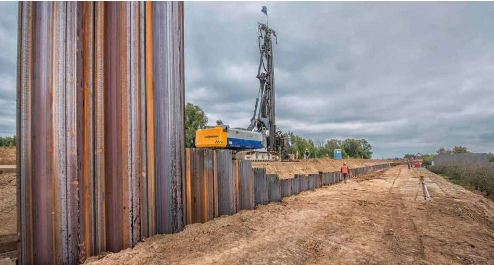
Damwand tegen piping (Opheusden).
