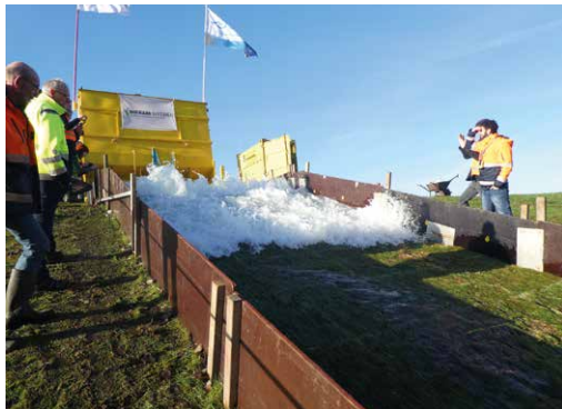
Proef met versterken grasmat binnentalud (Ijsseldijk bij Olst).
