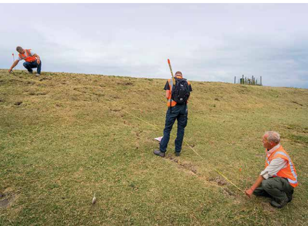
Dijkinspectie. Er wordt heel veel informatie verzameld. Daarmee kan uiteindelijk de hoogte van de dijk worden bepaald (Alblasserwaard).
