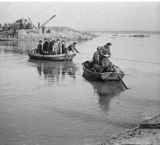
Burghsluis 1953. Dijkdoorbraak omdat het talud het begaf.
