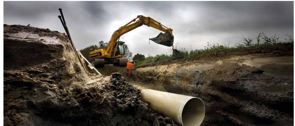
Het waterschap en de bedrijven die kabels en leidingen beheren werken samen op het moment dat de dijk wordt aangepakt. Het waterschap en de netbeheerders maken afspraken over de verdeling van kosten.
