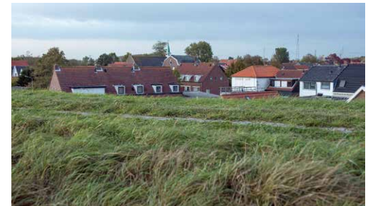
Hoe versterk je de dijk en houd je rekening met alles wat er direct achter de dijk ligt? (Hansweert)
