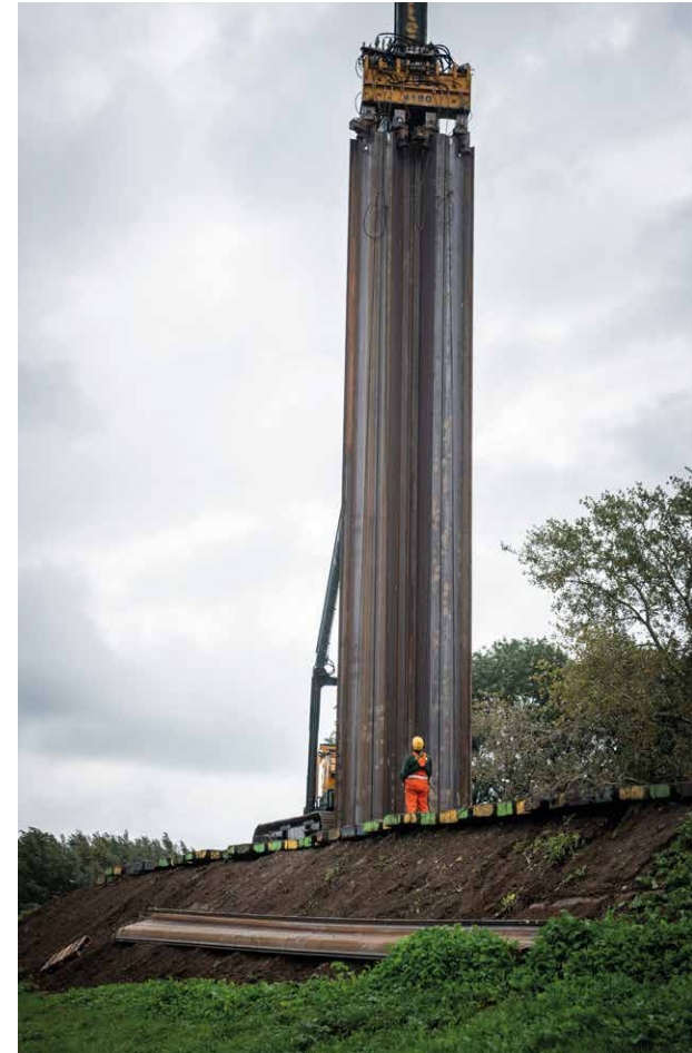
Een damwand die in de dijk gedrukt wordt (Vianen).
