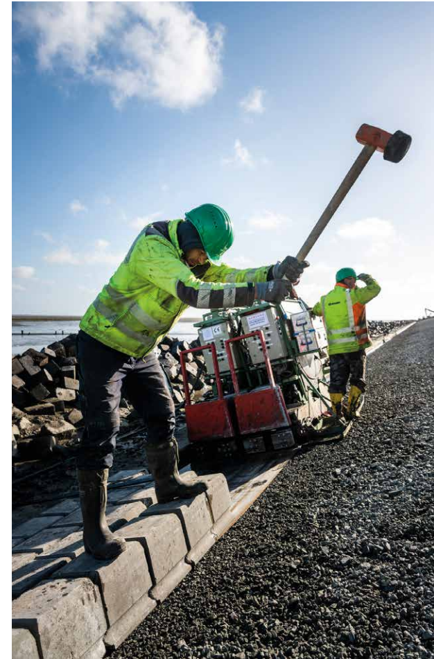
Verruwen buitentalud (Lauwersmeerdijk).
