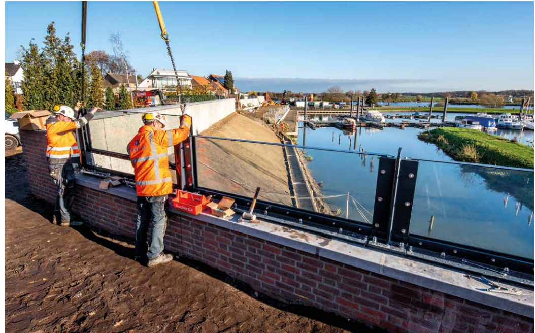
Het plaatsen van de glazen elementen (Neer).
